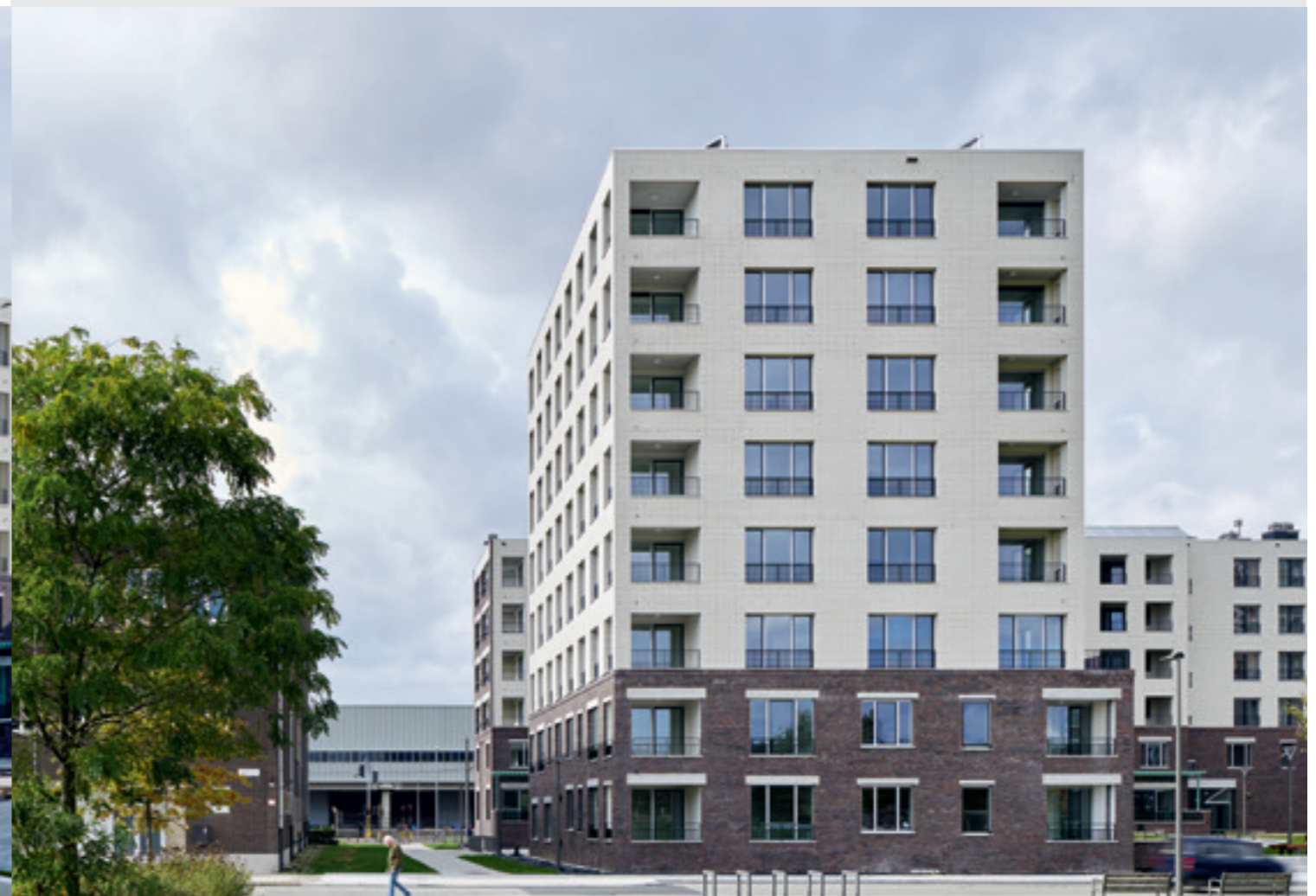
Der Kontrast von hellen und dunklen Klinkern schafft eine harmonische Gliederung der Mauerwerksflächen.
