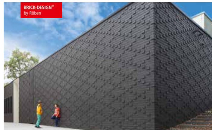
Objekt Schulmensa in Frankfurt/Main Architekten dirschl.federle_architekten Fassade Röben Klinker FARO schwarz-nuanciert, glatt, BRICK-DESIGN®
