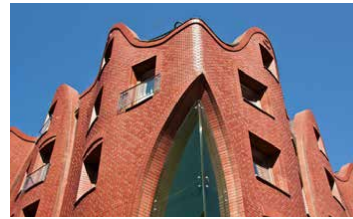
Objekt Hotel Fahrenheit in Danzig (PL) Architekten Architekturbüro Szotyński, Danzig Fassade Röben Klinker MELBOURNE, ziegelrot
