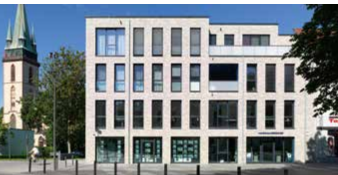
Kraftvoller Endpunkt - Wohn- und Geschäftshaus in Lünen, Seite 24
