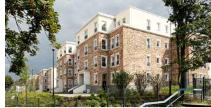
Wärme aus der Erde - Energieeffiziente Wohngebäude in Hagen, Seite 54
