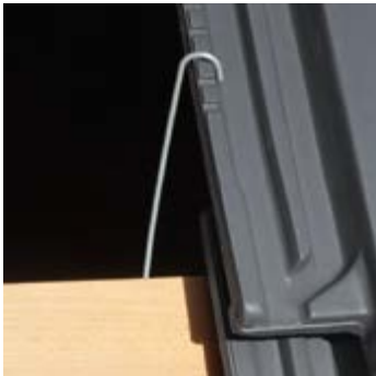
Die Fixierungskerben für die Sturmklammern.
