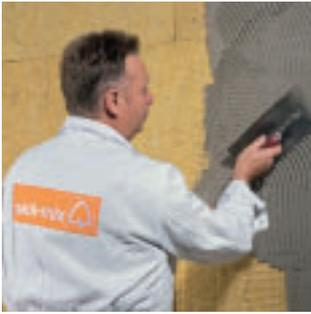
На теплоизоляционные плиты, в данном случае минераловатные, приклеивают Клеящим раствором для керамической плитки RKS, наносят первый слой армирующего раствора RAS толщиной ~ 5 мм. В него с помощью гладилки вдавливается утолщенная Армирующая сетка PUG.
