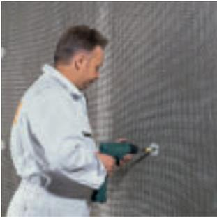
Затем через армирующую сетку PUG плиты крепят тарельчатыми дюбелями LOBATHERM и головки дюбелей шпаклюют RAS способом «мокрое по мокрому». Минимальная общая толщина армирующего слоя составляет 7 мм.
