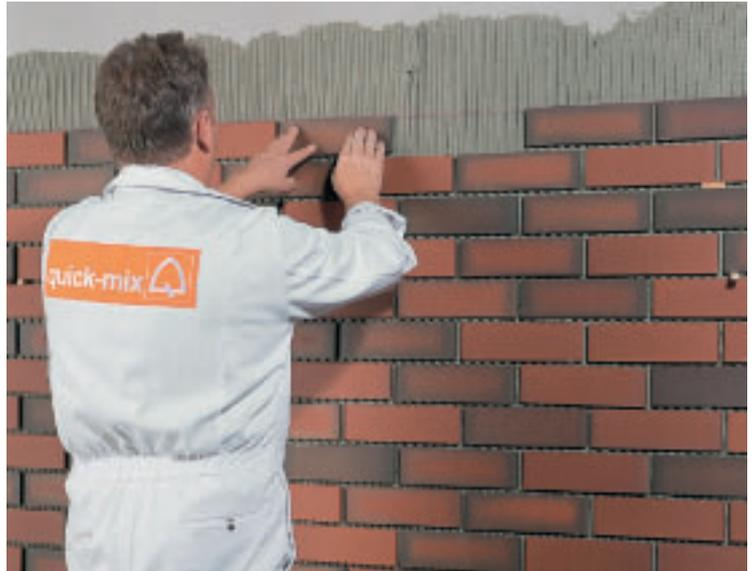
После полного затвердевания армирующего слоя приклеивают плитки методом «Buttering-Floating»: зубчатым шпателем (10x10 мм) наносят слой RKS на поверхность основания, в который вдавливают плитки, покрытые миллиметровым слоем RKS с изнаночной стороны.
